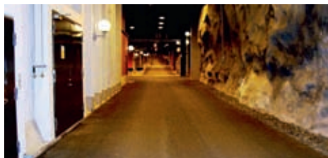
Ett nätverk av oändligt långa tunnlar finns i verket.
